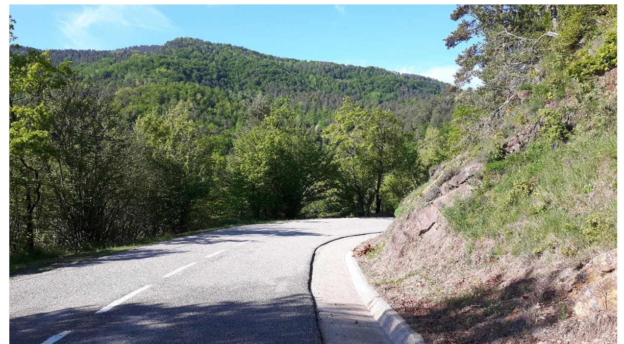
Fotografia núm. 36. Estat actual a l'altura del PK 2+720 de projecte.
