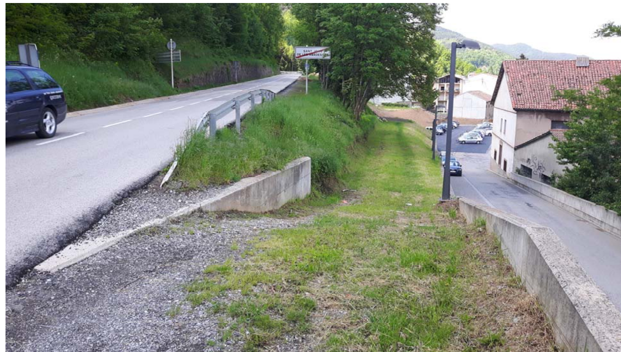
Línia d'enllumenat afectada per la via verda (Servei afectat n° 101)
