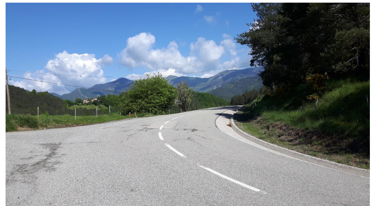
Fotografia núm. 20. Estat actual a l'altura del PK 1+660 de projecte.
