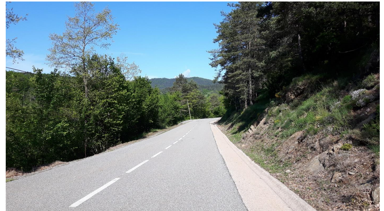
Fotografia núm. 35. Estat actual a l'altura del PK 2+660 de projecte.
