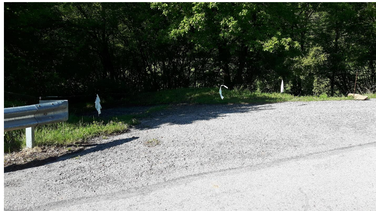
Fotografia núm. 32. Accés a parcel·la existent, a l'altura del PK 2+460.
