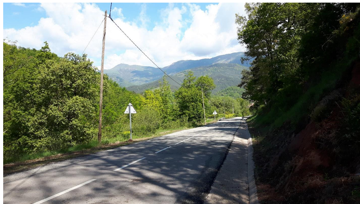
Fotografia núm. 14. Estat actual a l'altura del PK 0+900 de projecte.
