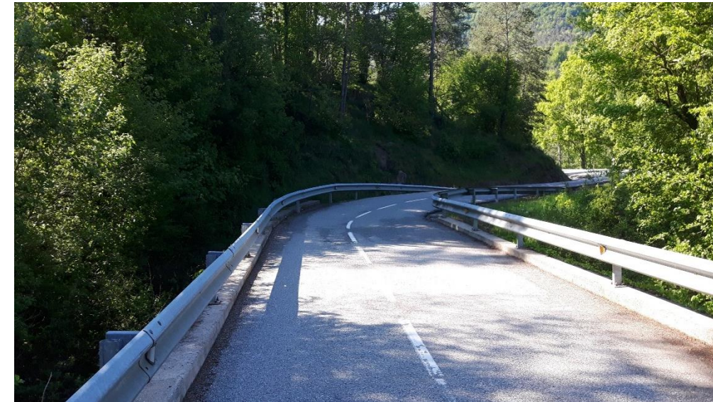
Figura 3: Tram del traçat en zona d'obra de fàbrica
