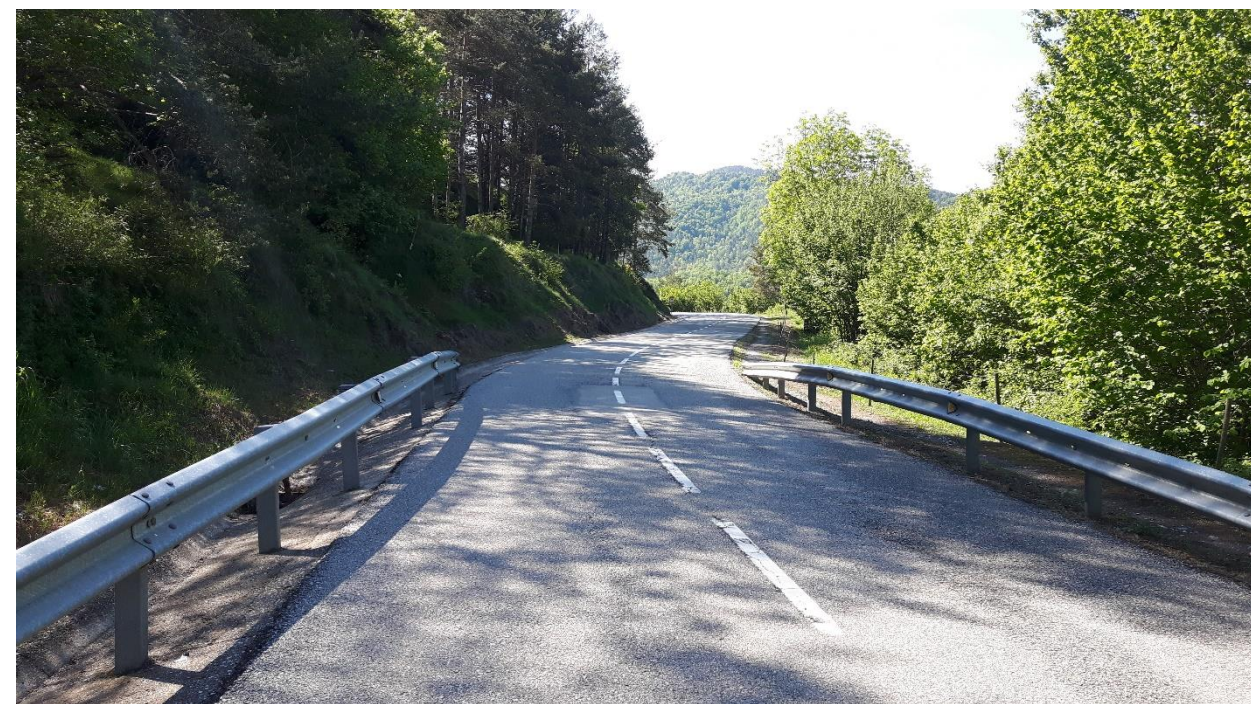
Fotografia núm. 16. Estat actual a l'altura del PK 1+140 de projecte.
