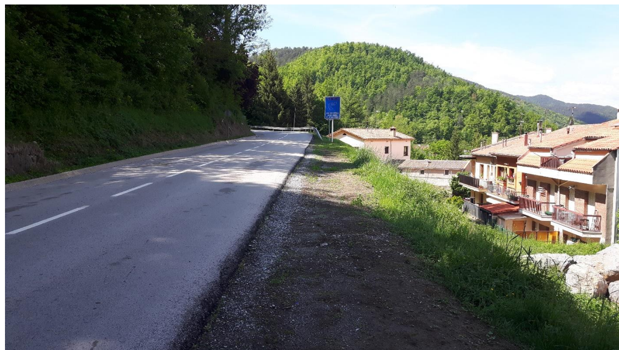
Fotografia núm. 2. Estat actual a l'altura del PK 0+120 de projecte.
