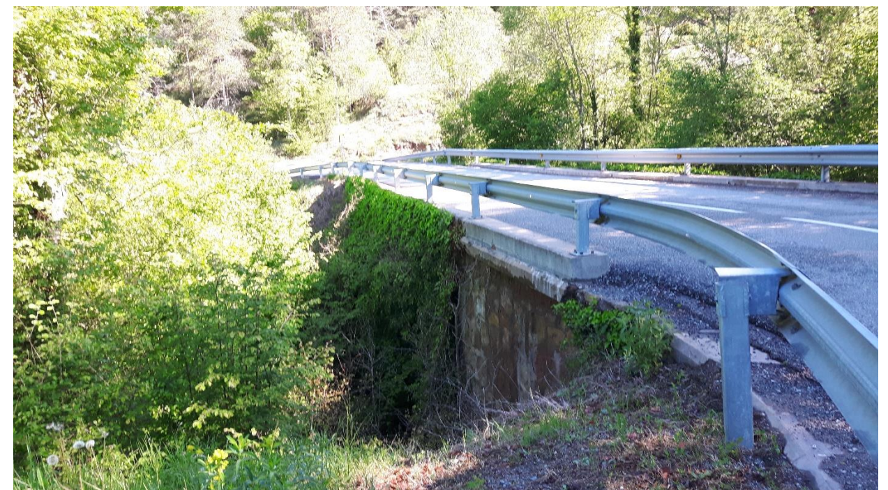
Fotografia núm. 28. Obra de fàbrica existent al PK 2+220 de projecte.
