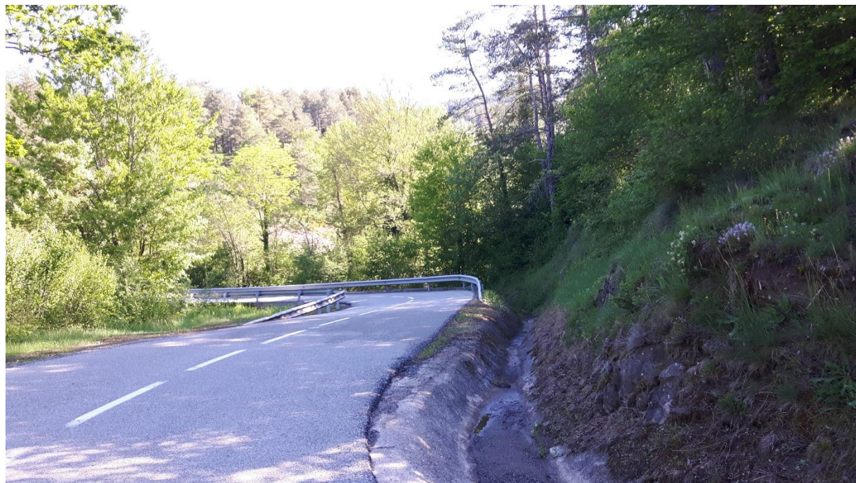
Fotografia núm. 30. Estat actual a l'altura del PK 2+260 de projecte.
