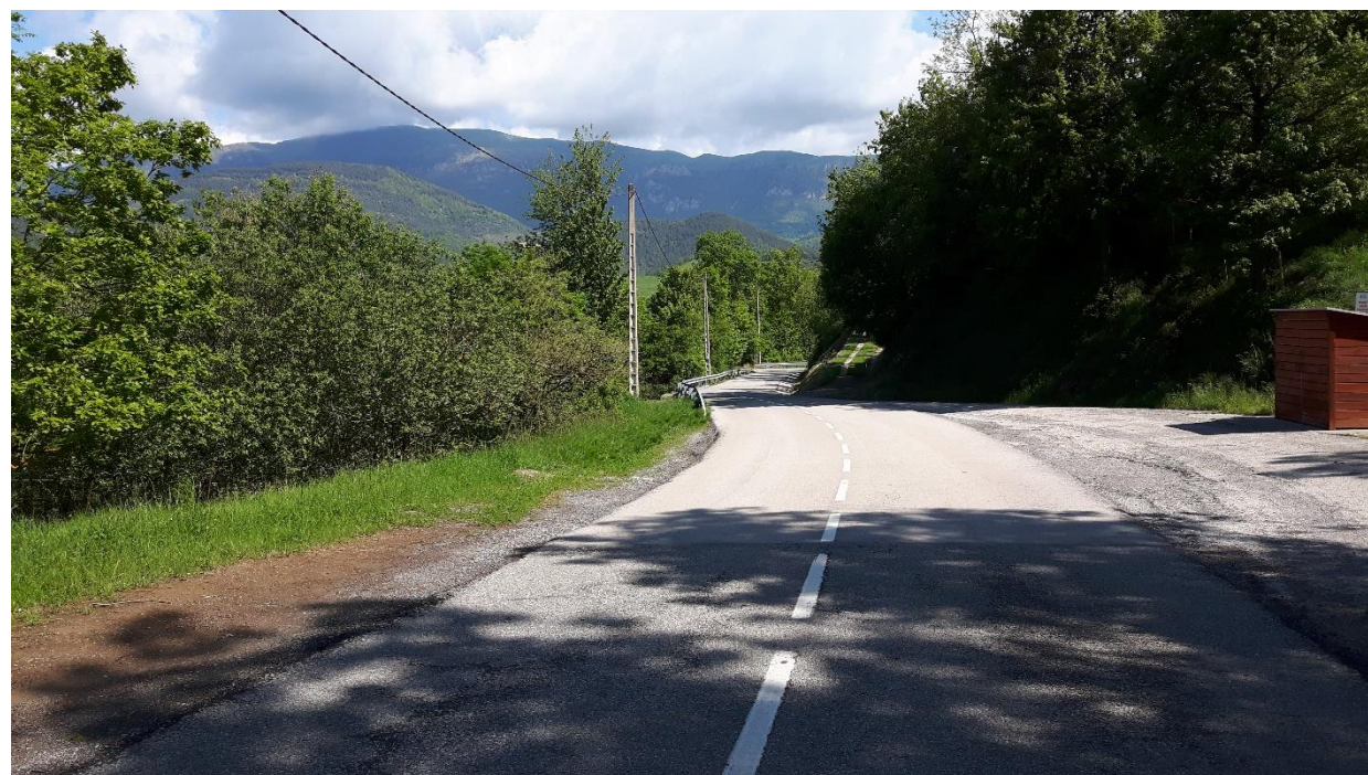
Fotografia núm. 10. Estat actual a l'altura del PK 0+660 de projecte.
