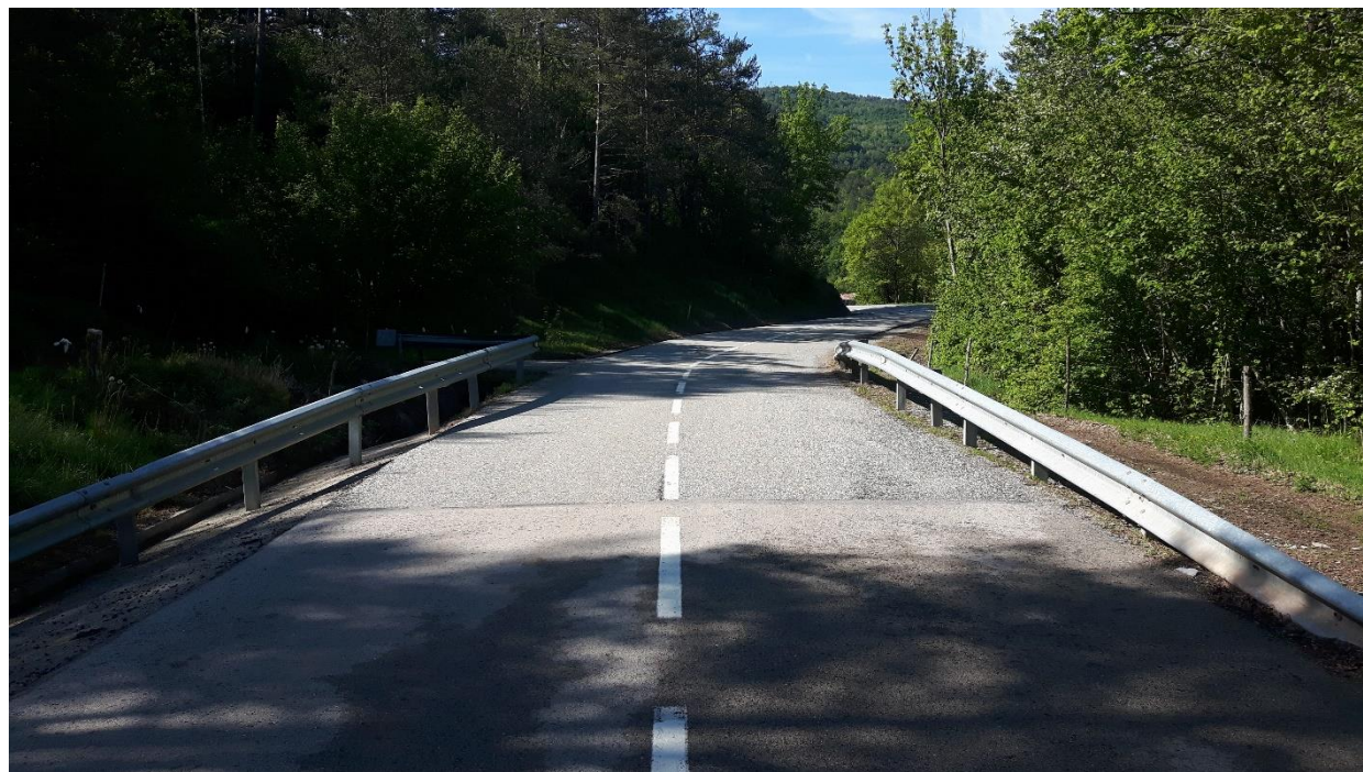
Fotografia núm. 22. Estat actual a l'altura del PK 1+820 de projecte.
