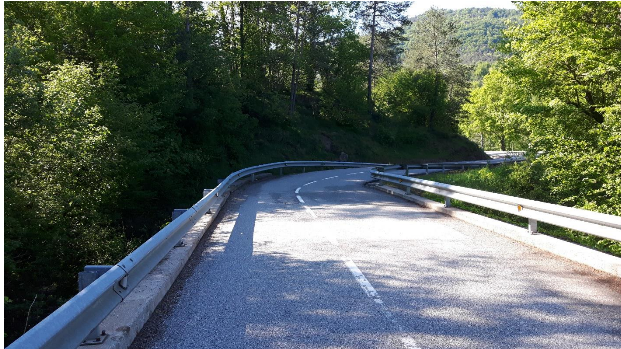
Fotografia núm. 29. Obra de fàbrica existent al PK 2+220 de projecte.
