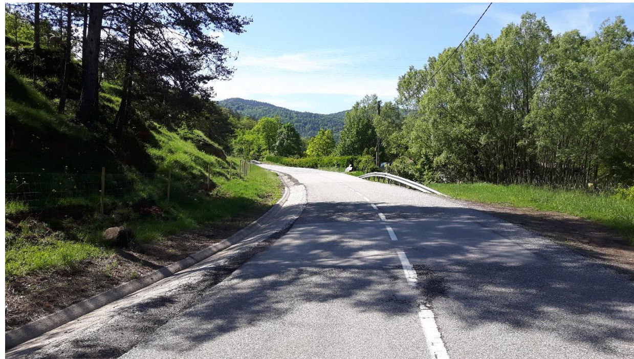
Fotografia núm. 9. Estat actual a l'altura del PK 0+620 de projecte.
