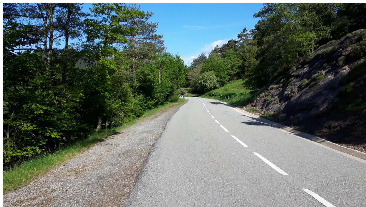
Fotografia núm. 34. Estat actual a l'altura del PK 2+540 de projecte.
