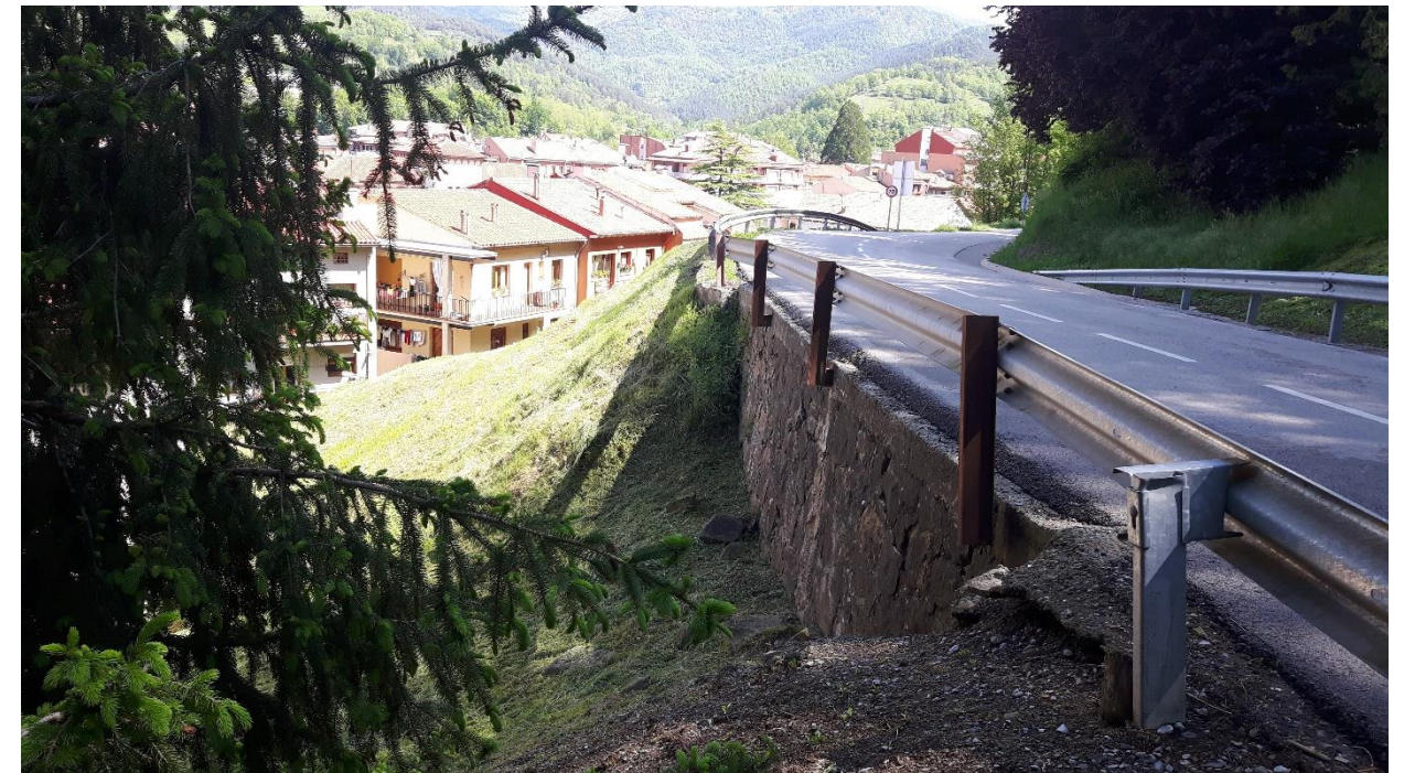
Fotografia núm. 3. Estat actual a l'altura del PK 0+220 de projecte.
