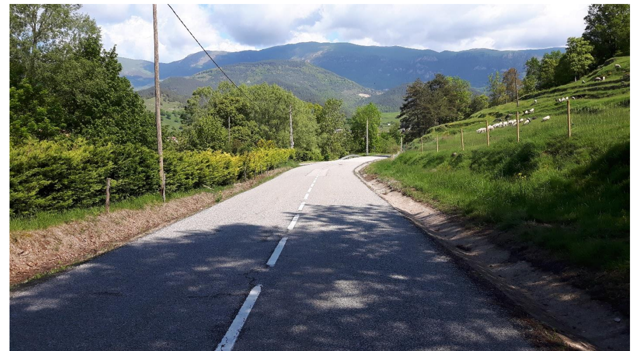
Fotografia núm. 12. Estat actual a l'altura del PK 0+820 de projecte.
