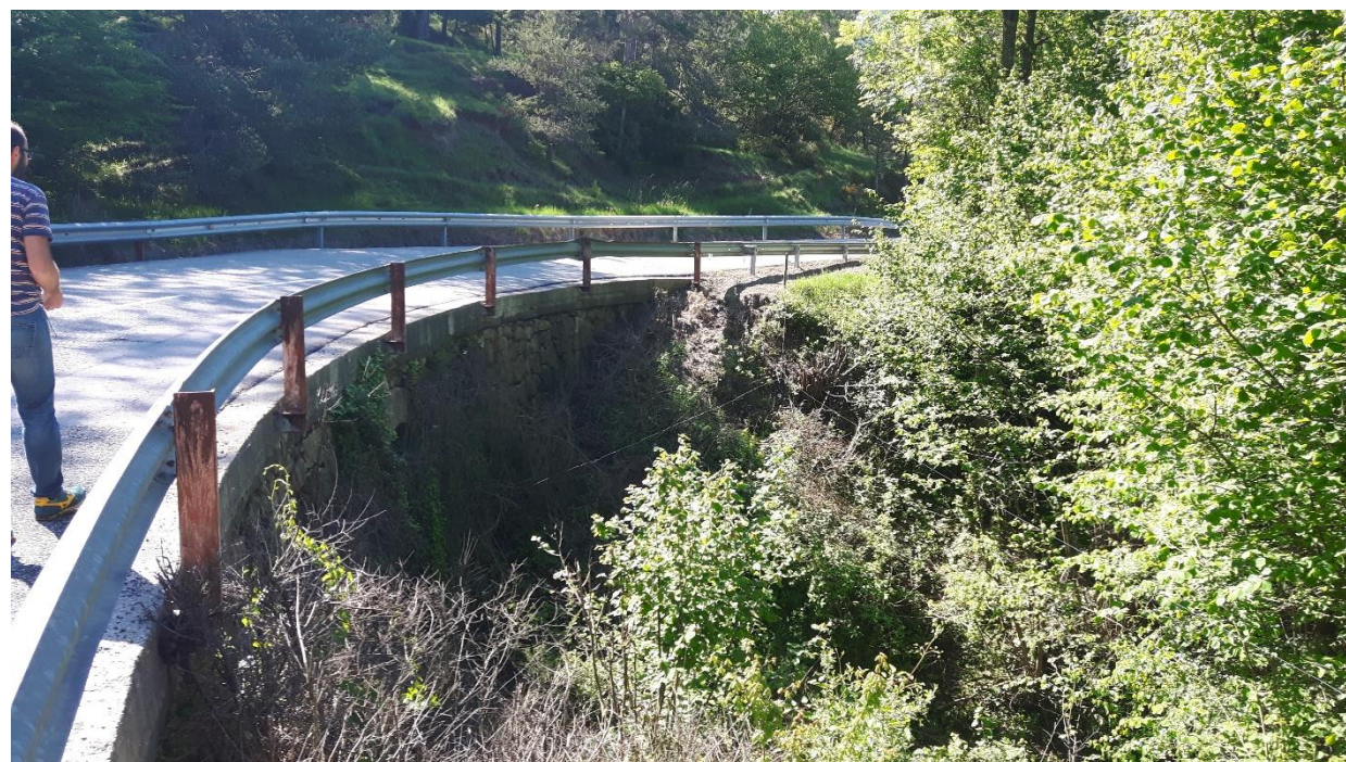
Fotografia núm. 18. Obra de fàbrica existent al PK 1+400 de projecte.
