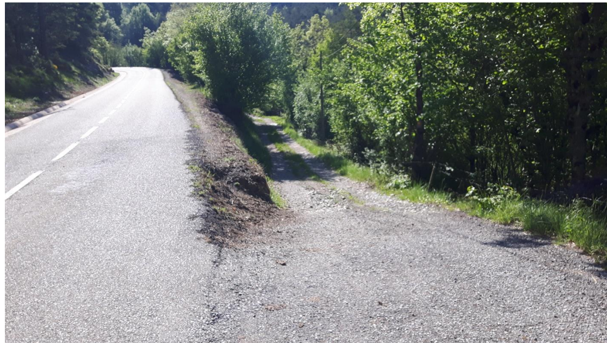
Fotografia núm. 33. Accés a parcel·la existent, a l'altura del PK 2+580.
