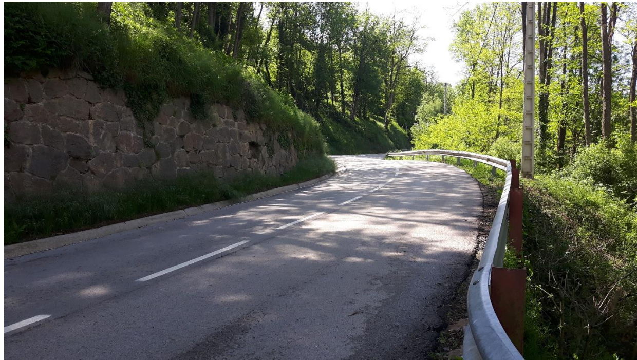
Fotografia núm. 5. Estat actual a l'altura del PK 0+340 de projecte.
