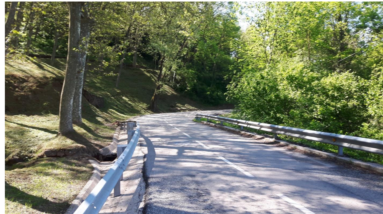
Fotografia núm. 15. Estat actual a l'altura del PK 1+080 de projecte.
