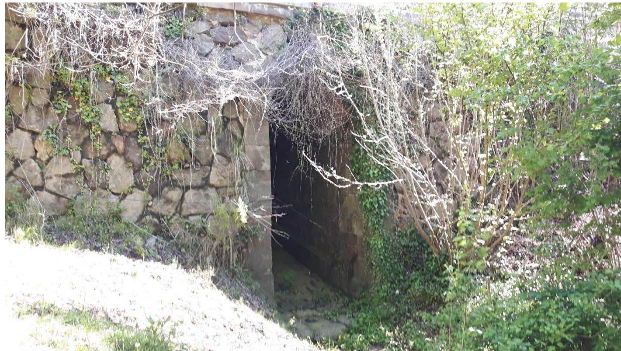
Fotografia núm. 25. Obra de fàbrica existent al PK 2+040 de projecte.
