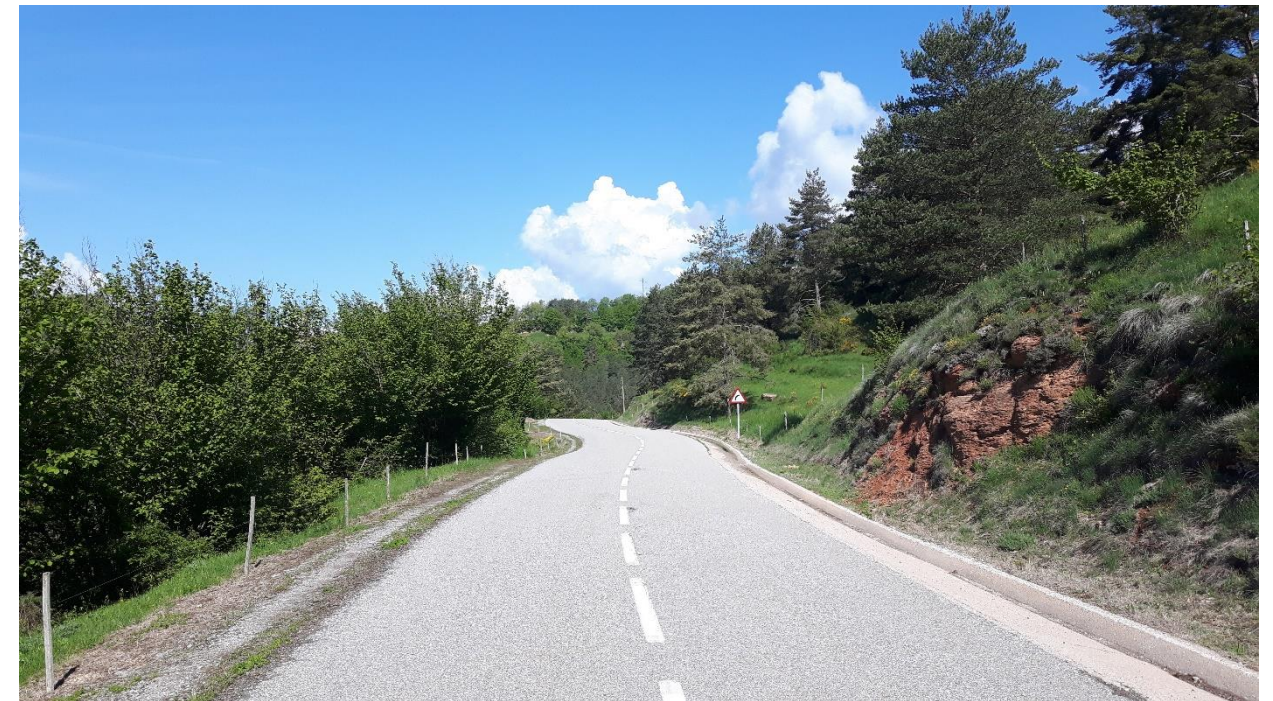
Fotografia núm. 19. Estat actual a l'altura del PK 1+600 de projecte.
