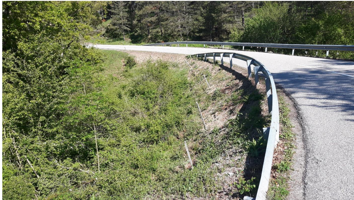
Fotografia núm. 21. Obra de fàbrica existent al Torrent del Querós, al PK 1+760 de projecte.
