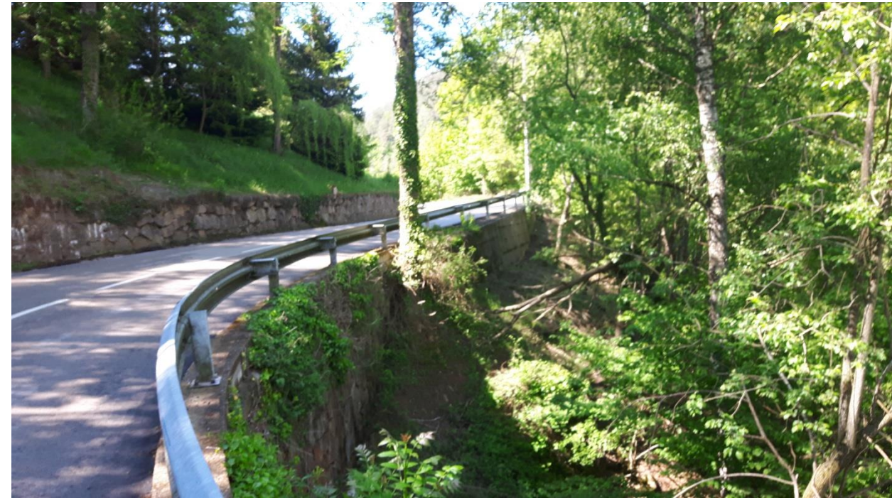
Fotografia núm. 7. Obra de fàbrica existent a l'altura del PK 0+460 de projecte.
