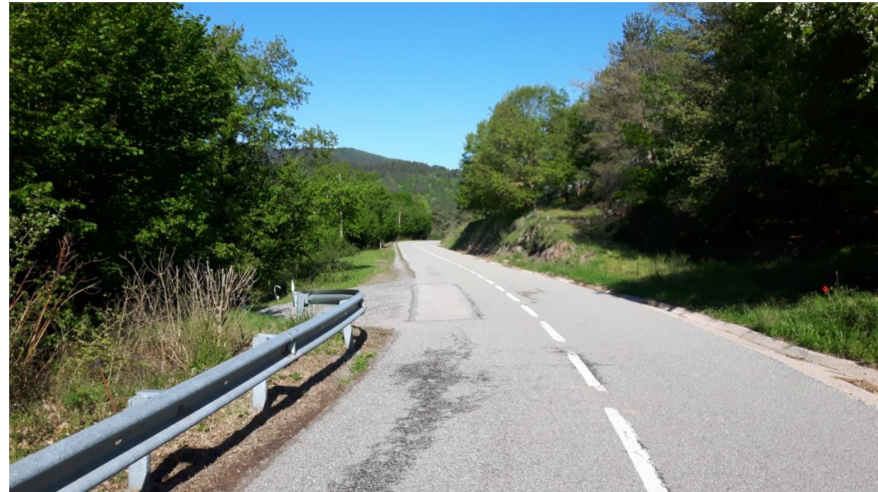
Fotografia núm. 31 Accés a parcel·la existent, a l'altura del PK 2+460.
