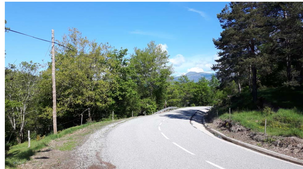
Línia de telefonia afectada per la via verda (Servei afectat n° 204)
