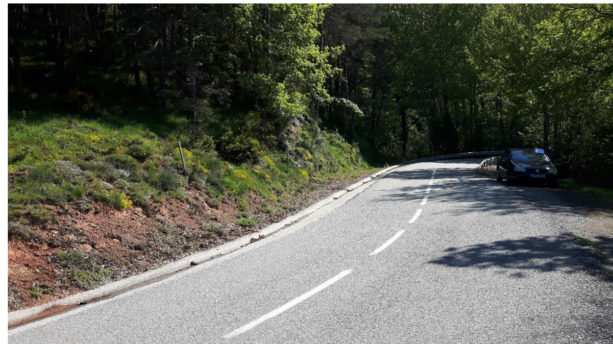
Fotografia núm. 24. Estat actual a l'altura del PK 2+000 de projecte.
