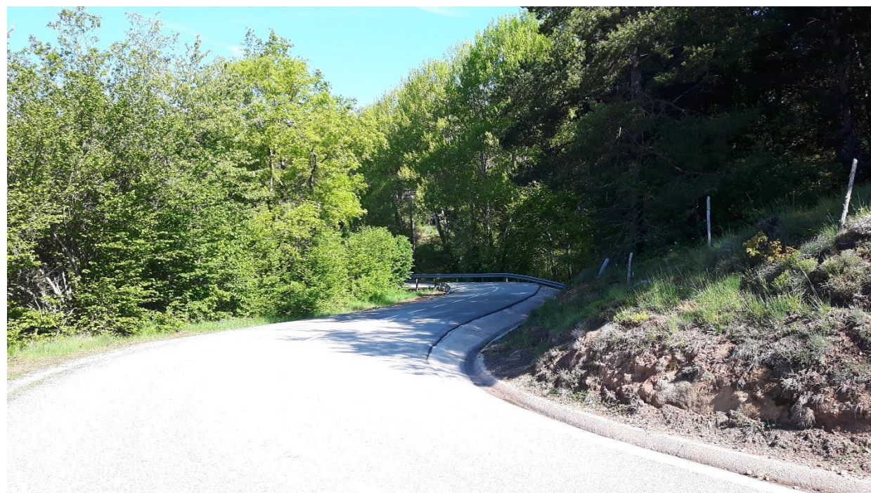
Fotografia núm. 26. Estat actual a l'altura del PK 2+120 de projecte.
