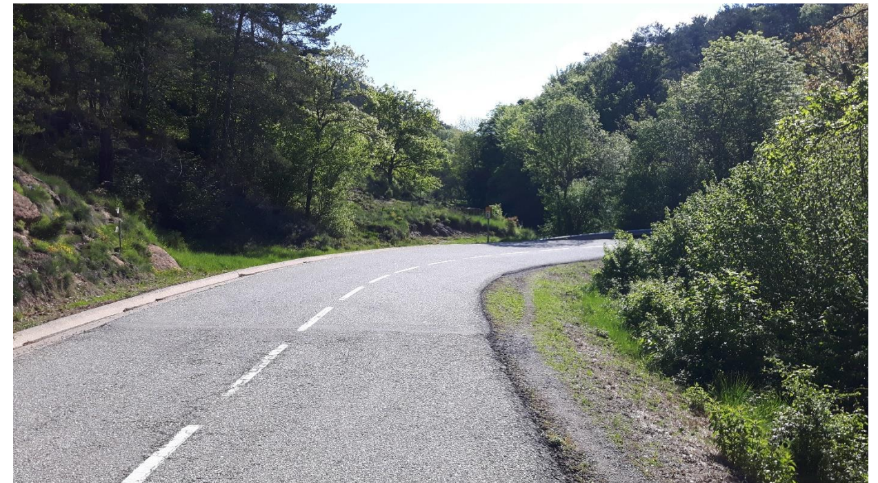
Fotografia núm. 27. Estat actual a l'altura del PK 2+170 de projecte.
